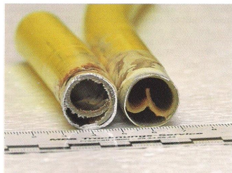
7 – Inliner suelto tras sollicitación térmica.
